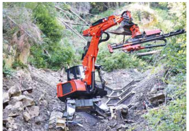
Die Verbauung des Baches wird mittels modernster Technik ausgeführt
