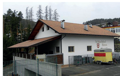
Am Schlachthof ist es notwendig für die Sicherheit des Personals und der Tiere, den Treibgang bzw. Zugang der Tiere zum Schlachtraum durch den Einbau von verschiedenen Schleusen und Geländern zu verbessern
